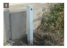
メーターボックス内の止水栓を閉め、配管内の圧力を抜いた後蛇口を取り外してください。
