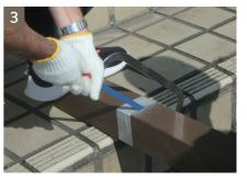
穴底面から既設水栓柱の蛇口取付位置中心まで の高さに合わせて水栓柱カバーを金属用ノコギ リ等で切断してください。
