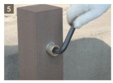
シールテープを巻き付けた延長金具(ザルボ)を 既設水栓柱の蛇口取付部にねじ込んでください。 ねじこむ際は六角スパナ(六角対辺12mm)を使用 してください。
