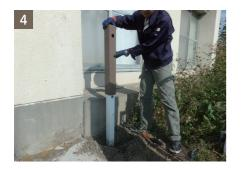
切断した水栓柱カバーを既設水栓柱に被せ、延 長金具(ザルボ)と蛇口のネジ部にシールテープ を7~8周巻き付けてください。
