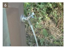
給水ザガネを取り付け、延長金具(ザルボ)に蛇口をねじ込んでください。水が漏れないことを確認して作業は終了です。
