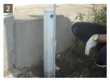
木調水栓柱カバーよりひとまわり大きく深さ約5cmの穴を掘り、穴の底面から既設水栓柱の蛇口取付位置中心までの高さを測定してください。
